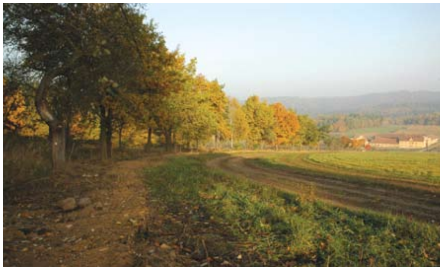
Případ, kdy nebyly dodrženy podmínky stavebního rozhodnutí na vedení výkopu pro elektrické vedení (foto archiv ČSOP Vlašim)
